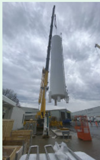
Positioning the LNG storage vessel
